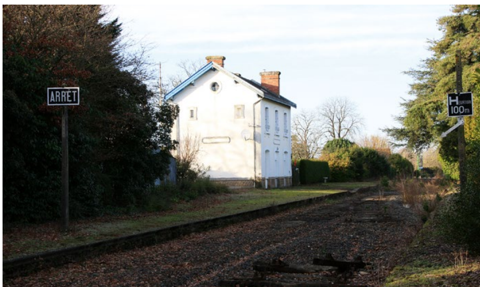
Un transport public en site propre sur l'ancienne ligne de chemin de fer.
